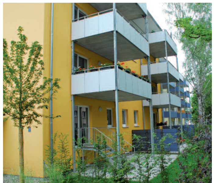
Großzügige Vorstellbalkone mit bodengleichen Übergängen in die Wohnungen runden die Sanierungsmaßnahme ab.
