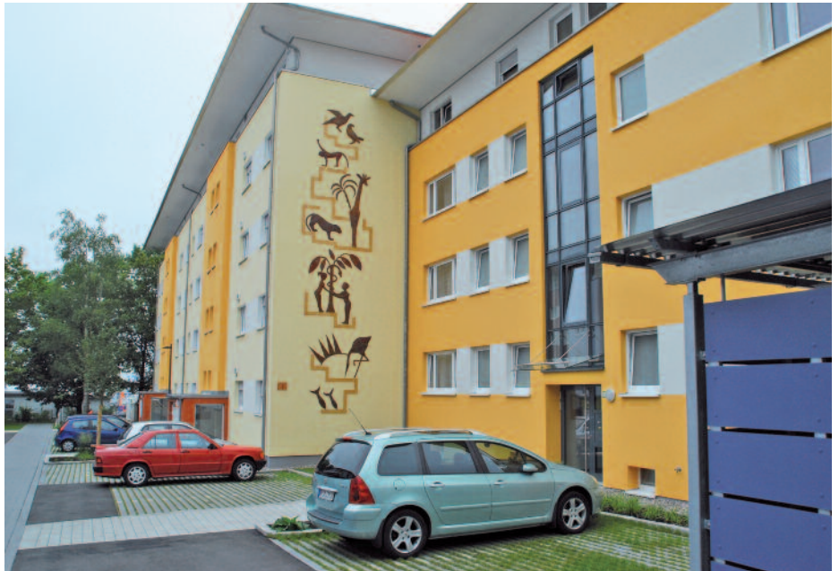
Die drei Gebäude in der Leibnizstraße erstrahlen nach der Sanierung in neuem Glanz. Auch das Nachkriegskunstwerk konnte dank der aufwendigen Restaurierung gerettet werden.
