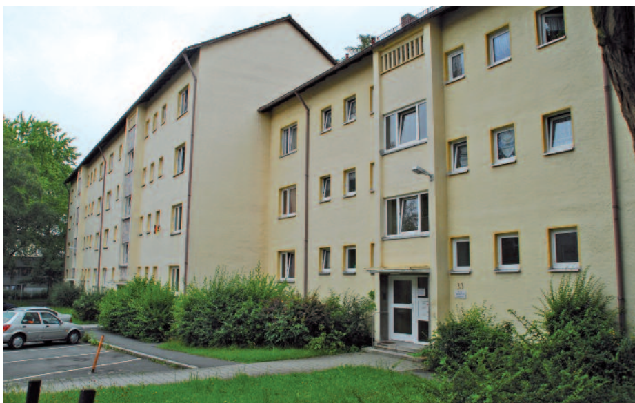
So wie dieser benachbarte Gebäudezug sah das Wohnobjekt in der Leibnizstraße 21 bis 25 vor der Sanierung aus.
