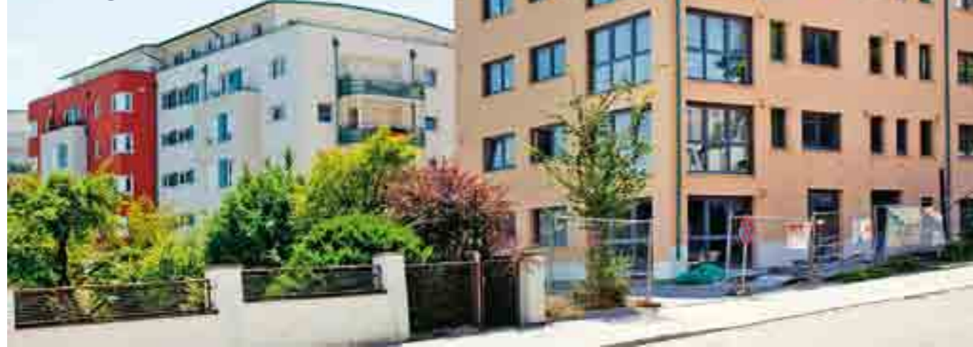
Die Wohnungen im Studentenwohnheim an der Galgenbergstraße in Regensburg sind mit Wohnraumlüftungen ausgestattet
