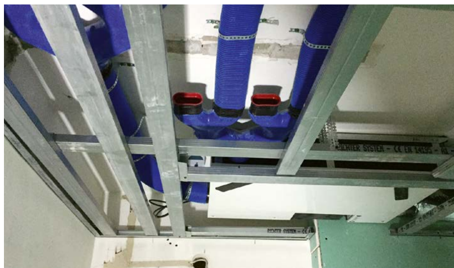
Das PluggPlan Lüftungsgerät und die Lüftungsleitungen von Pluggit sind so kompakt, dass sie ohne Probleme in die abgehängten Decken mit einer Revisionsöffnung integriert werden können.
