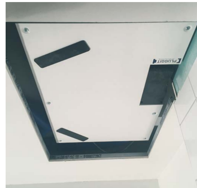
Die geringe Aufbauhöhe (170 mm) des PluggPlan Lüftungsgeräts von Pluggit erlaubt den verdeckten Einbau in der Zwischendecke der Bäder und die einfache Wartung durch die Revisionsöffnung.
